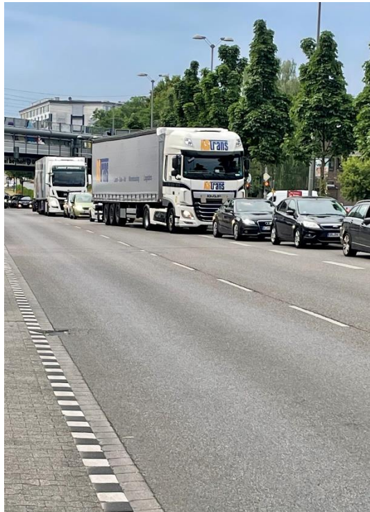
Abbildung 20: Sperrung der benachbarten Fahrspur aufgrund ungenügender Fläche für linksabbiegende Fahrzeuge
